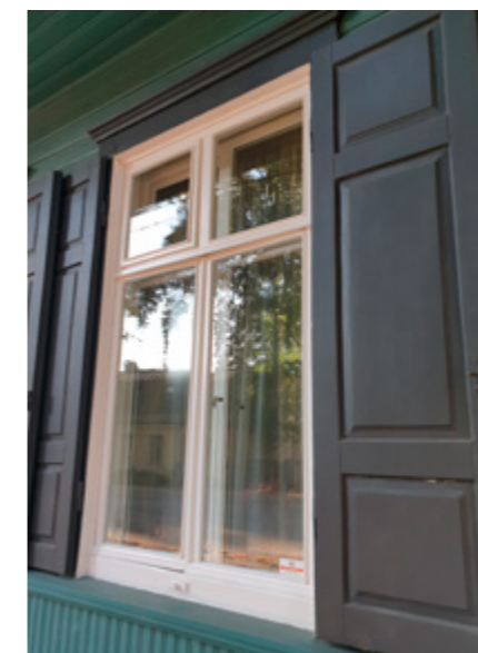
Pušų g. 35. Restauruotame name išsaugoti autentiški langai.
